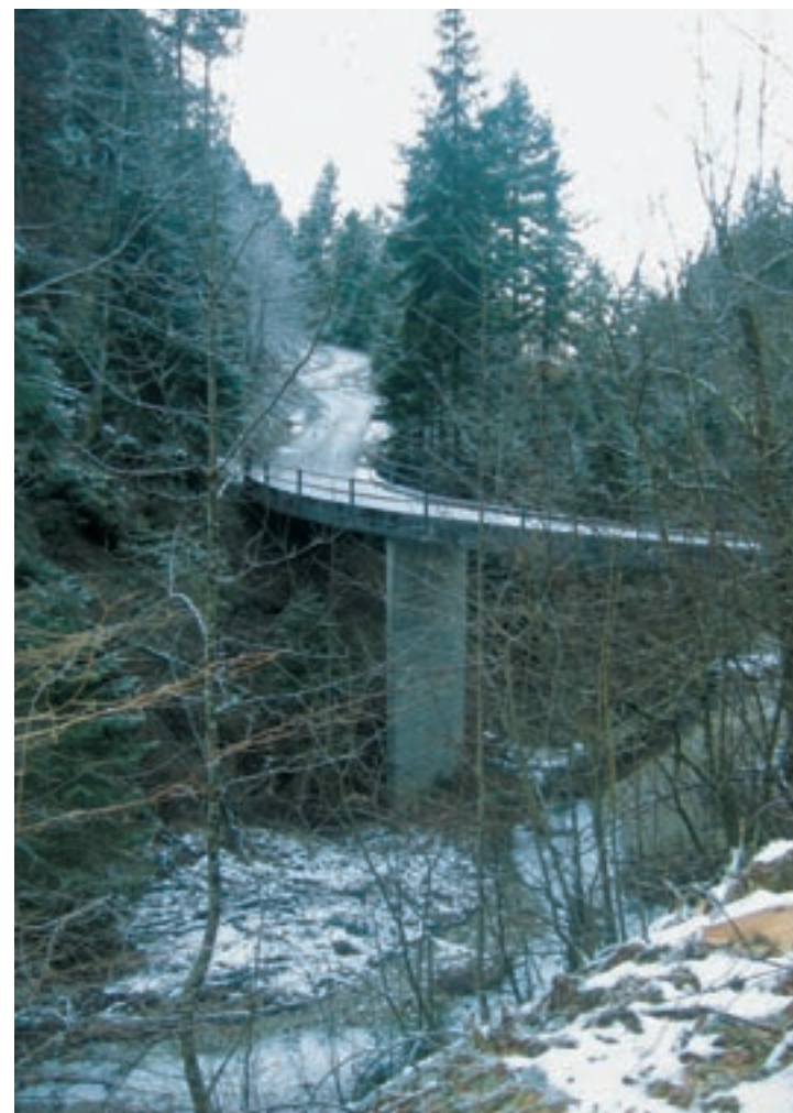
Die Seilkranbringung erfordert eine solide Basiserschliessung
