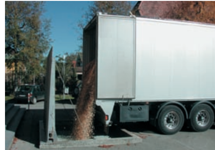
Holzanlieferung für Holzheizkessel
