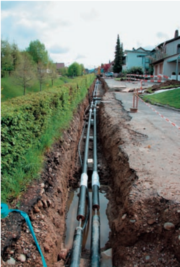
Fernheizungsleitungen in Sumiswald soweit das Auge reicht
