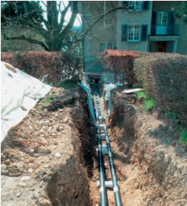
Verlegte Leitungen für Fernwärme, Bahnhofstrasse Sumiswald
